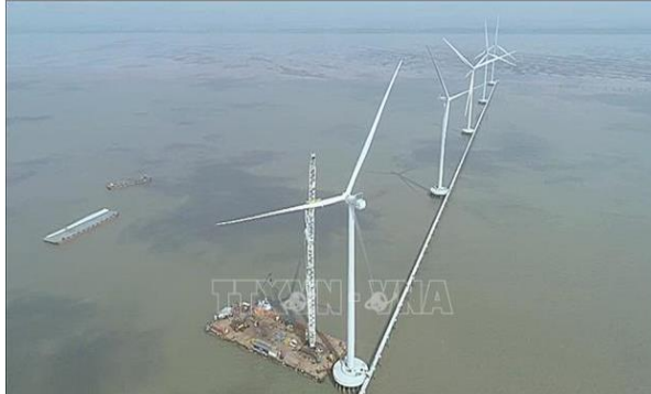
Lắp đặt cánh quạt trụ điện tại Dự án điện gió Đông Hải 1 (huyện Đông Hải, tỉnh Bạc Liêu). Ảnh minh họa: Chanh Đa/TTXVN
