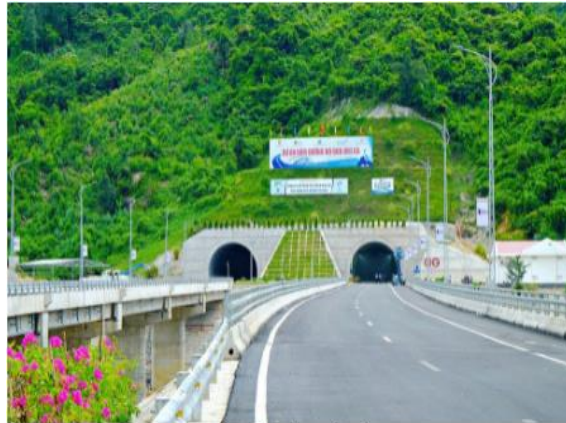
Hầm đường bộ qua Đèo Cả
